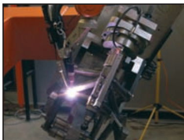
Роботизированная сварка угловых и V-образных швов с одним скосом двух кромок и зазором в 2 мм с использованием системы MagicWave 4000
