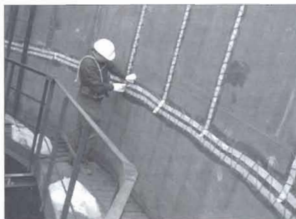
Рис. 1. Монтаж заряда ВВ
