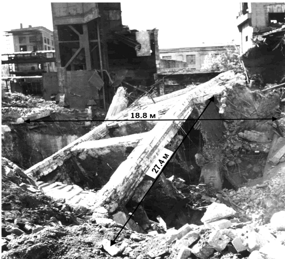
Рис. 1. Общий вид провала на стволе № 5 шахты им. Н. Изотова
