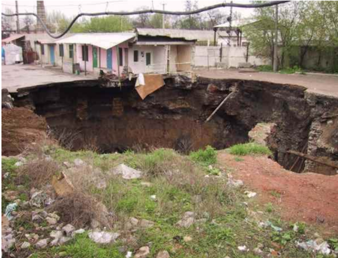
Рис. 4. Общий вид провала стволе № 6-14
