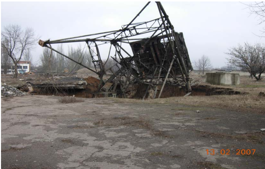
Рис. 3. Общий вид провала восточного воздухоподающего ствола шахты "Октябрьский рудник"
