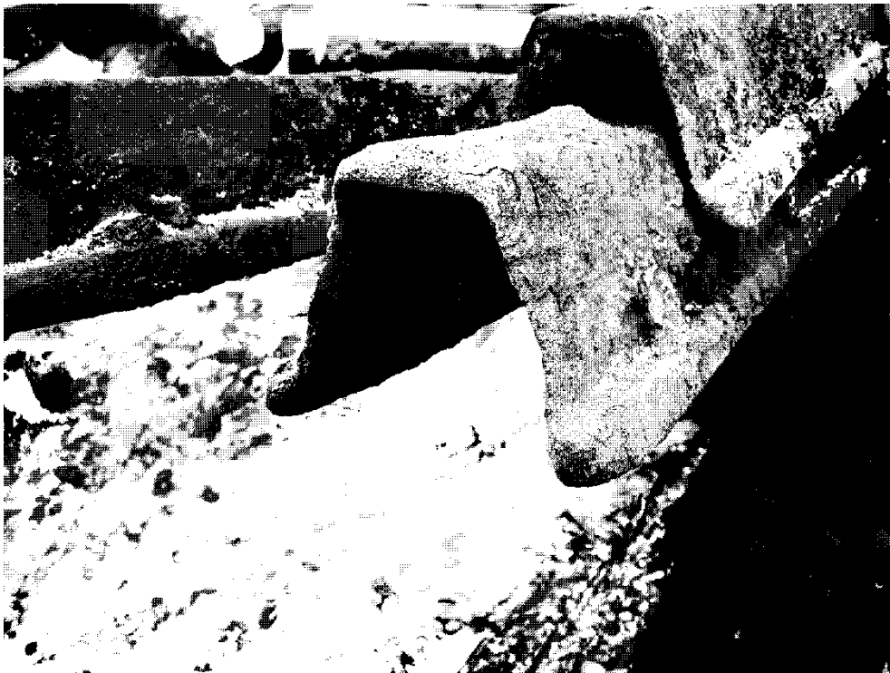
Рис. 9. Явление самозатачивания концов стоек арочной крепи при внедрении их в породы почвы. Шахта «Свято-Андреевская»
