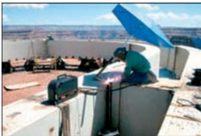
При соединении балок коробчатого сечения выигрыш в производительности был обеспечен в основном за счет сварки последовательными дугами. При одной дуге переменного и другой постоянного тока операторы использовали цифровую кнопочную систему управления на PowerFeed® 10 А для задания частоты колебания, уравновешивания и амплитуды для получения оптимальной комбинации проплавления и
