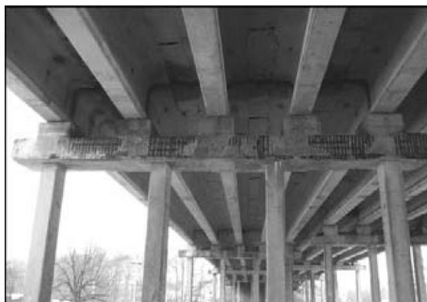
Рис. 1. Общий вид железобетонных конструкций автодорожного моста после 19 лет эксплуатации
