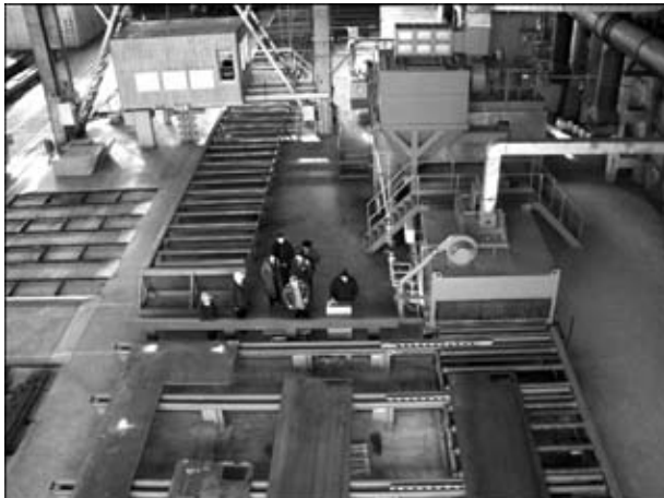
Рис. 5. Линия дробеструйной очистки и грунтовки фирмы «Гутманн»
