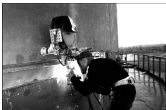
Выполнение сварки горизонтального шва
