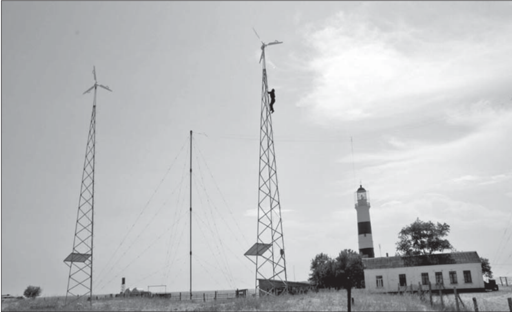
Рис. 3. Автономна вітро-сонячна система на острові Тендрівська коса
