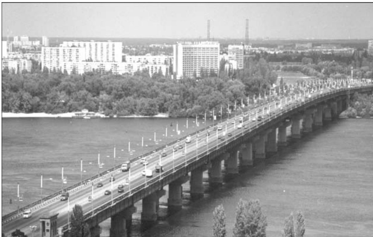
Рис. 1. Общий вид цельносварного моста им. Е. О. Патона через р. Днепр в Киеве
