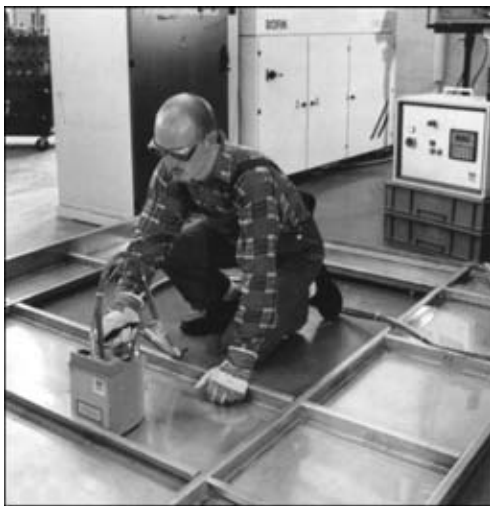
Рис. 2. Лазерная сварка листовых конструкций с помощью переносного аппарата LHSG-1
