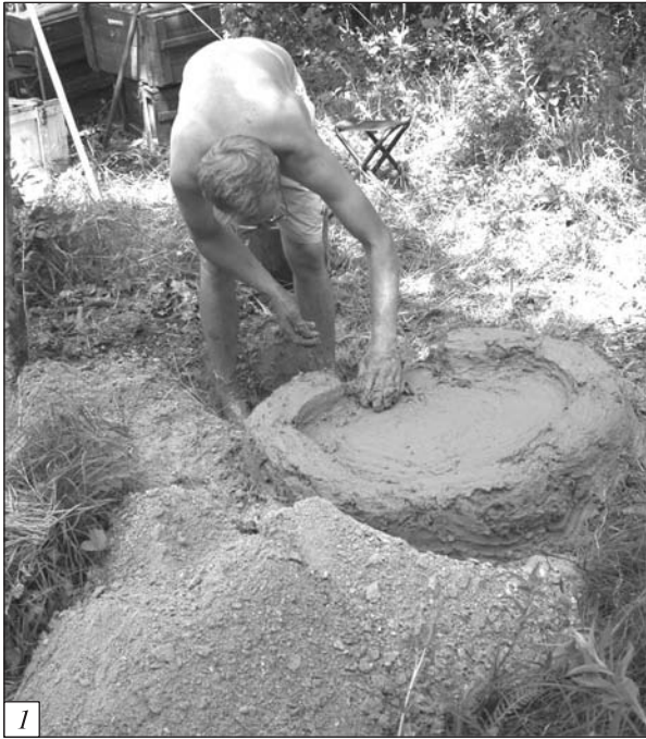
Рис. 8. Експеримент із побудови глинобитної печі: 1 — черинь і нижня частина купола; 2 — піч у завершеному вигляді до початку використання
