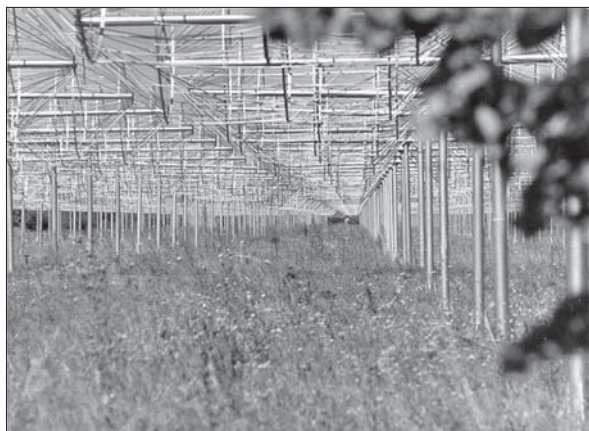
Рис. 1. Найбільший у світі радіотелескоп декаметрових хвиль УТР-2; f = 8\text{--}32 МГц, A = 150\,000 м 2 , N = 2040
