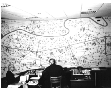
РИС. 3. Фрагмент диспетчерского щита городских кабельных сетей г. Николаева с графо-лучевой компоновкой мнемосхемы
