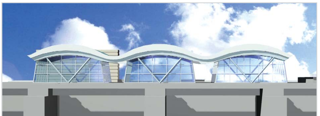
Рис. 2. Полоцька ГЕС. Світловий ліхтар машинного залу
