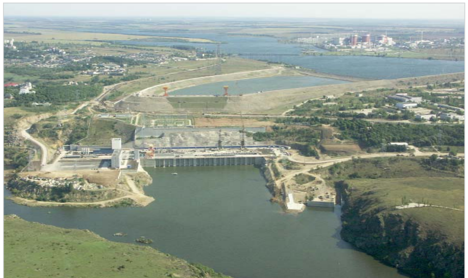
Панорама строительства Ташлыкской ГАЭС
