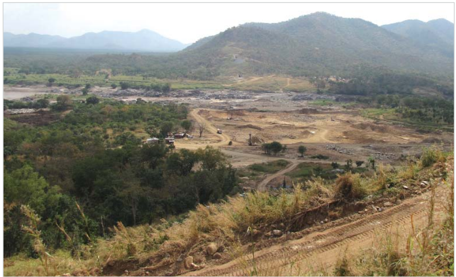
Строительство ГЭС "Великая плотина Эфиопского возрождения"
