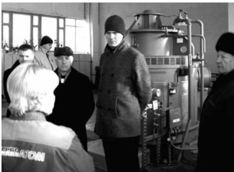
Слухачі факультету підвищення кваліфікації НУВГП у насосній станції ХАЕС
