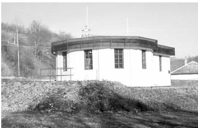
Рис. 1. Дериваційна міні-ГЕС у с. Білин Закарпатської області (будівля міні-ГЕС)
