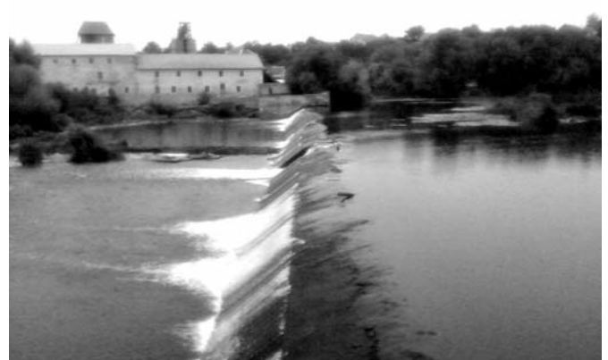
Рис. 4. Автоматична водозливна гребля на р. Случ у м. Новоград-Волинський (біля міського водозабору) (можливий створ
