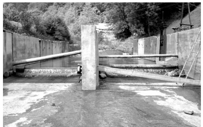
Рис. 2. Гірська водозабірна споруда в складі міні-ГЕС у с. Білин Закарпатської області
