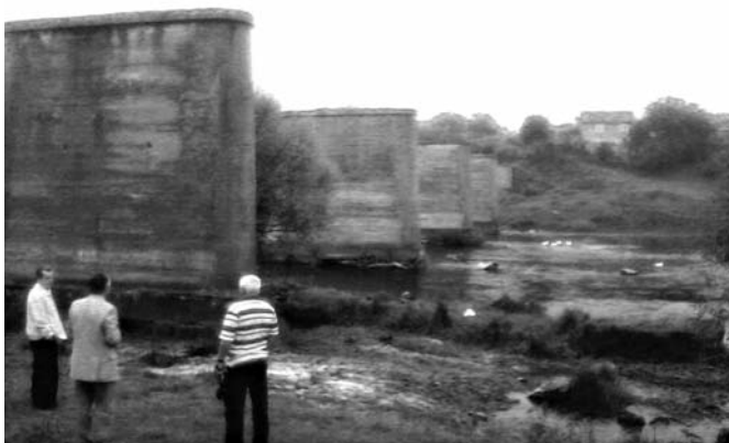
Рис. 3. Створ і опори зруйнованого моста на р. Случ у м. Новоград-Волинський (можливий створ міні ГЕС)
