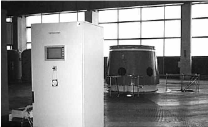
Рис. 5. Система СТК для гидрогенератора Красноярской ГЭС (гидроагрегат № 2) (мощностью 500 МВт, 416 точек контроля)
