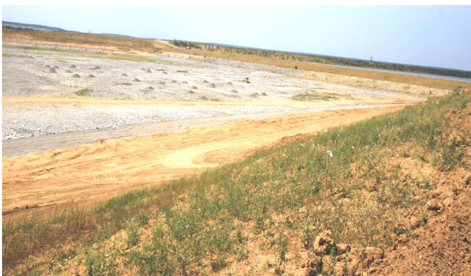
Рис. 2 - Будівництво другої черги екрану верхового басейну Дністровської ГАЕС (укладка захисного кам'яного накиду поверх екрану)
