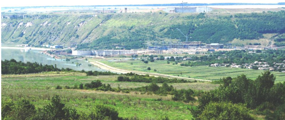
Рис. 1 - Вид з лівого берега Дністра на будівництво Дністровської ГАЕС
