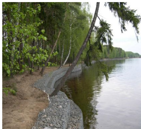
Рисунок 10 – Приклад габіонного укріплення берега
