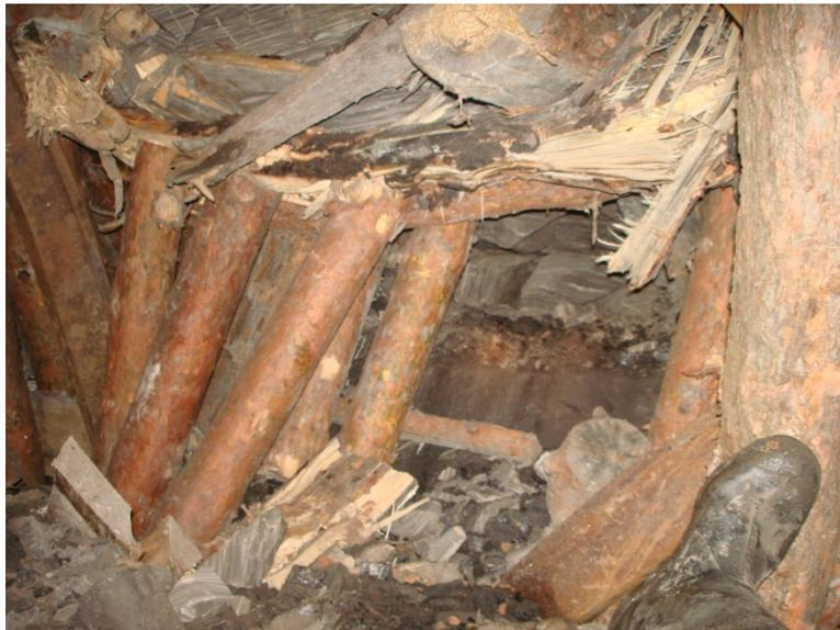
Рис. 1. Деформирование стоек установленных по бровке
