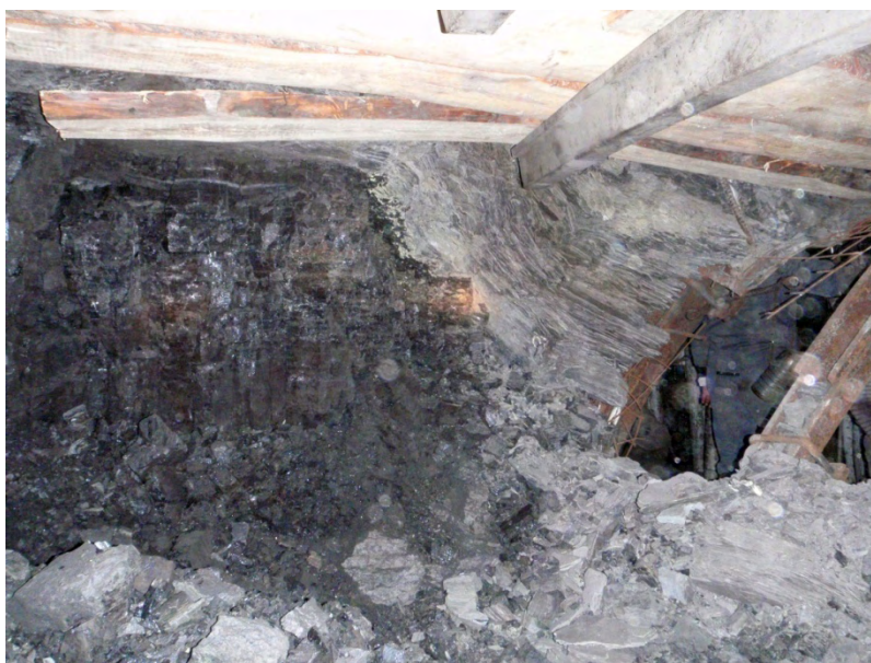
Рис. 2. Состояние горного массива в бортах выработки в условиях шахты «Степная»
