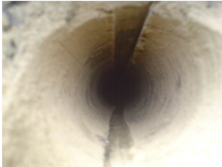
Рис. 2. Изображение незакрепленной скважины диаметром 75 мм, полученное с помощью телевизионного устройства
