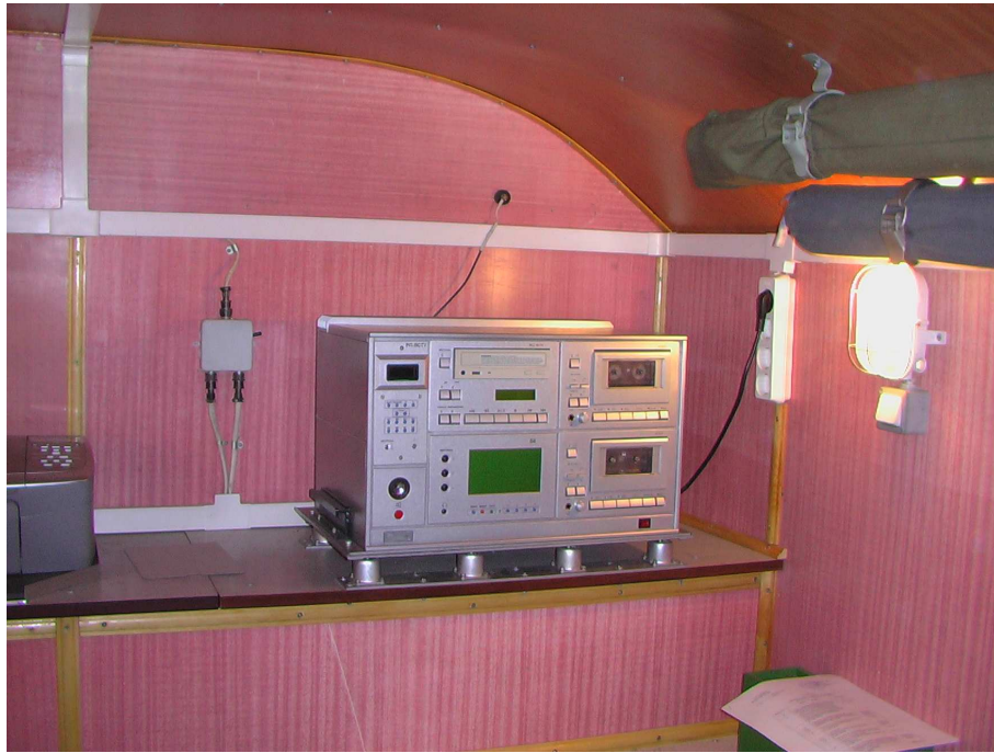
Рис. 3. Військова стереофонічна радіотрансляційна установка ВСТУ-50 (у складі ПКВС)
