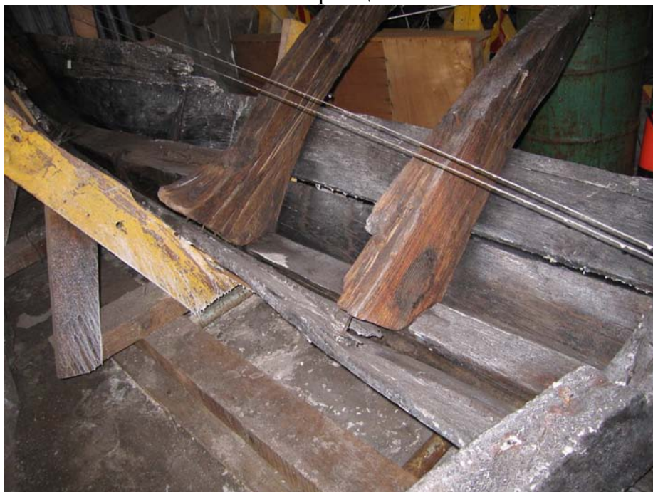
Фото 26. Консервация корпуса судна.
