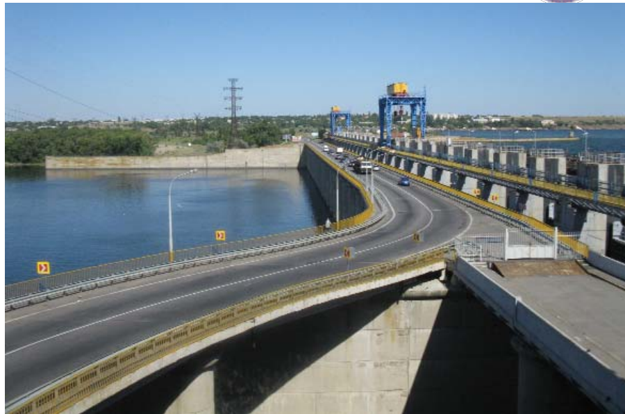
Каховская ГЭС, водосливная плотина
