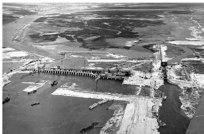
Строительство Каховской ГЭС
