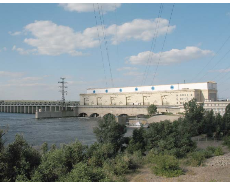
Каховская ГЭС - вид с нижнего бьефа
