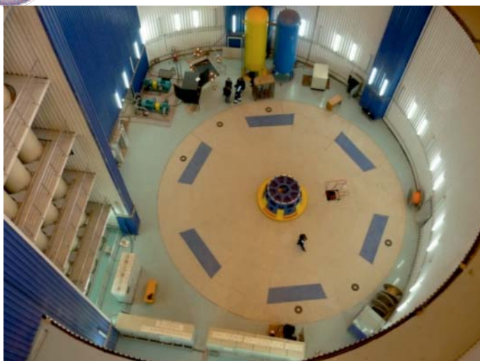
Иллюстрация 1. Отметка 56.600 с установленными панелями.
