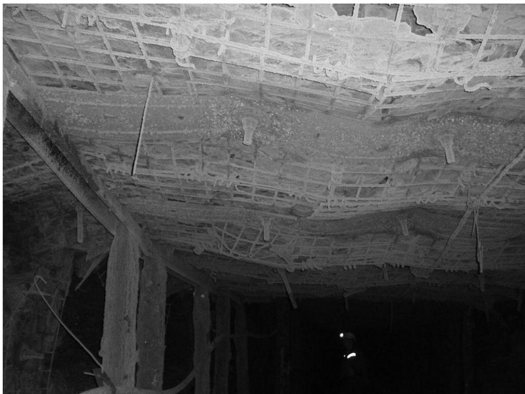
Рис. 2 – Состояние пород кровли 875 сборного штрека при его поддержании вне зоны влияния лавы на ПК 42
