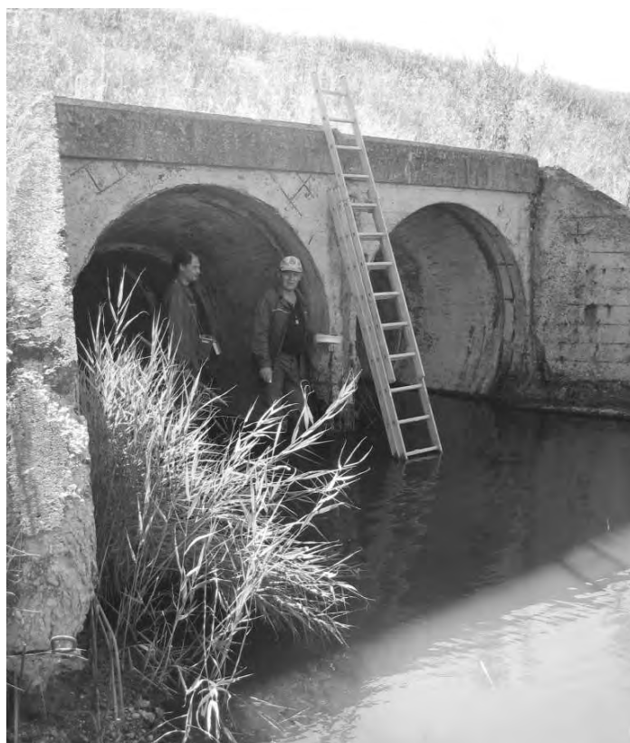
Рис. 2 – Внешний вид водопроводящих сооружений
