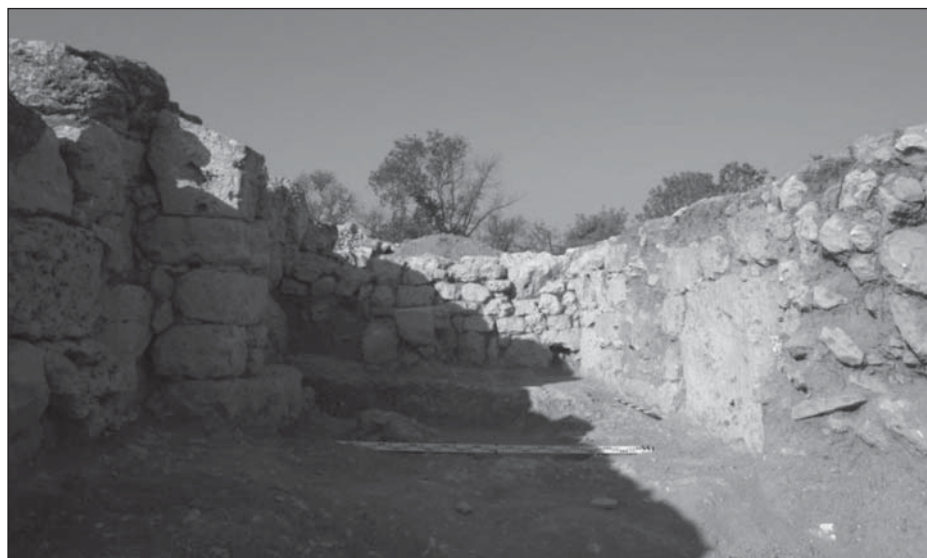
Рис. 1. Балка Бермана. Опорный столб арки
