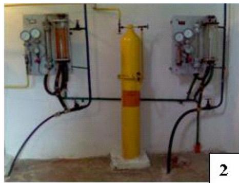
1- горизонтальный отстойник и здание хлораторной; 2 - дозаторное отделение хлораторной, с установленными хлораторами ЛОНИИ-100 (1 рабочий, 1 резервный).
