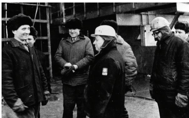
Рис.5. З.И.Некрасов на строительстве ДП№9 «Криворожстали».
