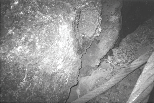
Рис.4. Вид области тугоплавких материалов горна доменной печи №8 ОАО «Криворожсталь» после частичной обрезки, 2005 г.
