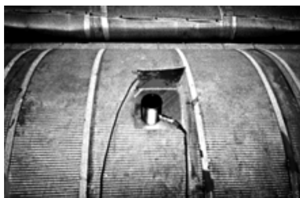
Рис. 7. Акустоемісійний контроль трубопроводів
