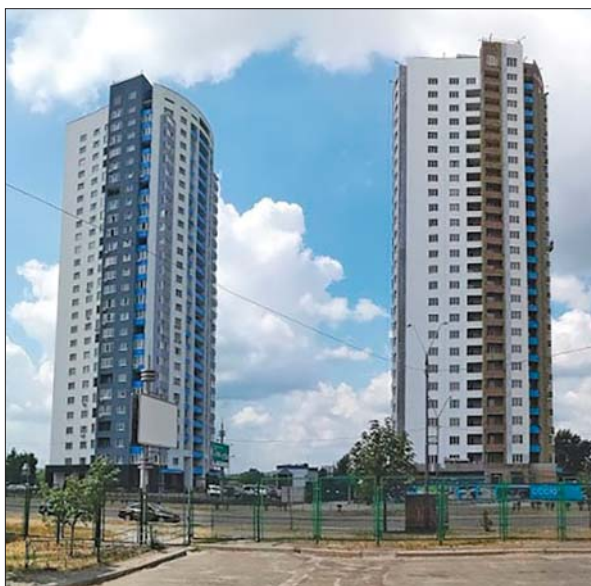
Сейсмоізольовані 27-поверхові будинки, зведені із застосуванням розробок Інституту геотехнічної механіки ім. М.С. Полякова НАН України. Київ, Оболонський проспект
