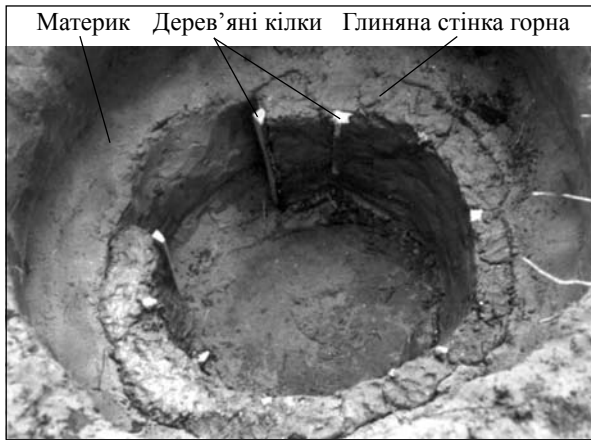
Рис. 3. Будівництво топкової камери експериментальної моделі в Ходосівці
