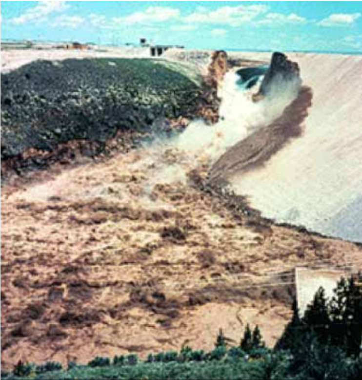
Рис. 2. Руйнування кам'яно-земляної греблі Тетон у 1976 році
