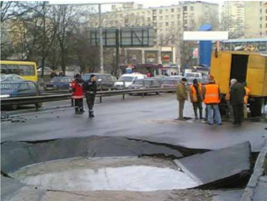
Рис. 4. Котлован діаметром 8 м з водою
