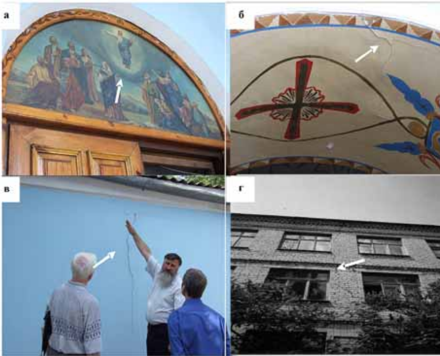
Рис. 8. Випадки порушення будівель від промислових вибухів у Кривому Розі. (фотографії автора)
