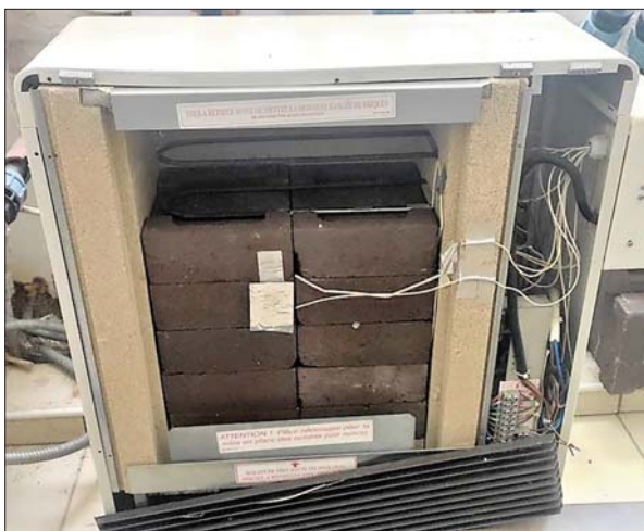
Рис. 4. Електричний твердотілий добовий теплоакумулятор на магнетитній кераміці
