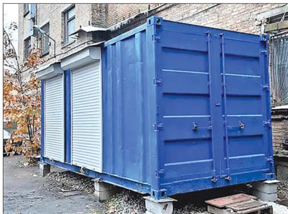
Рис. 3. Мобільний тепловий акумулятор потужністю 0,5 МВт
