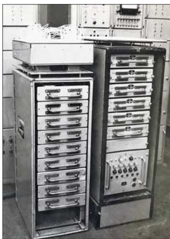
Аспірант Віталій Боюн біля створеного ним цифро-аналогового комплексу на базі КМШП «Дніпро-1» та електронної моделювальної установки ЕМУ-10. 1970 р.
