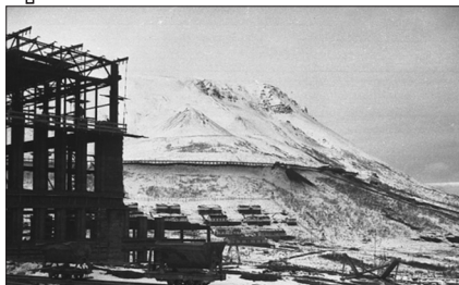
Будівництво Нікелевого комбінату в'язнями. На задньому плані видно бараки.
