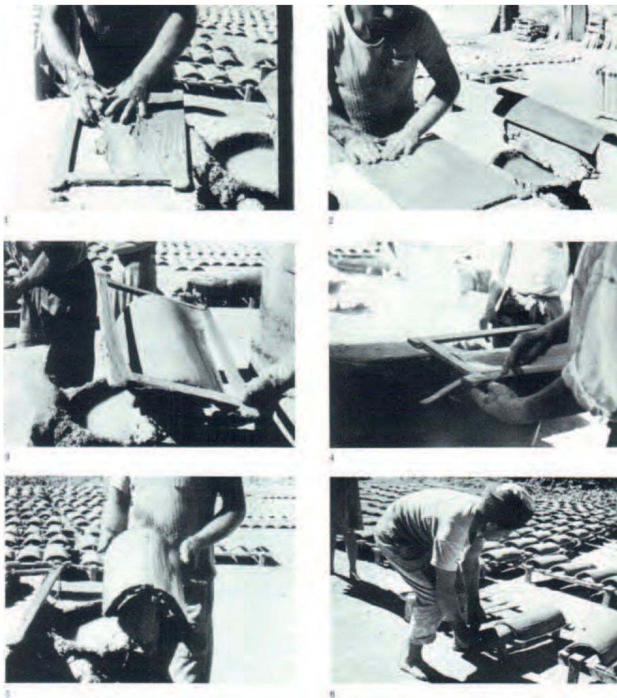
Рис. 3.30. Процесс изготовления калиптеров в г. Сегеста, Сицилия (по: Hampe, Winter 1965: Taf. 42).
