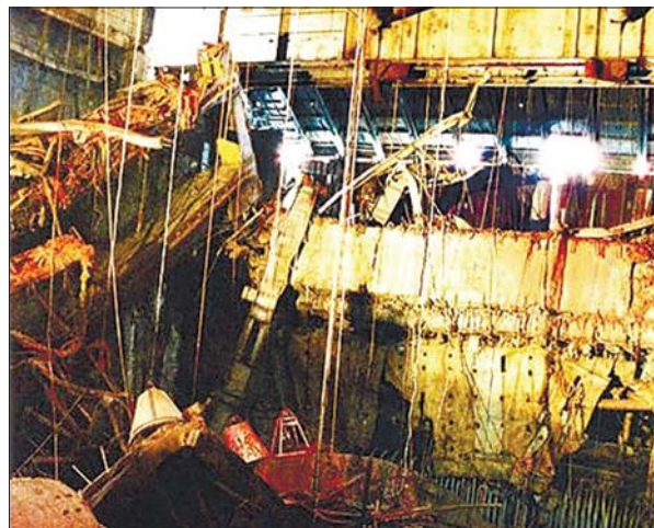
Зруйновані будівельні конструкції четвертого енергоблоку ЧАЕС
