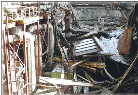
Обвал переkritтя південної частини машинного залу
