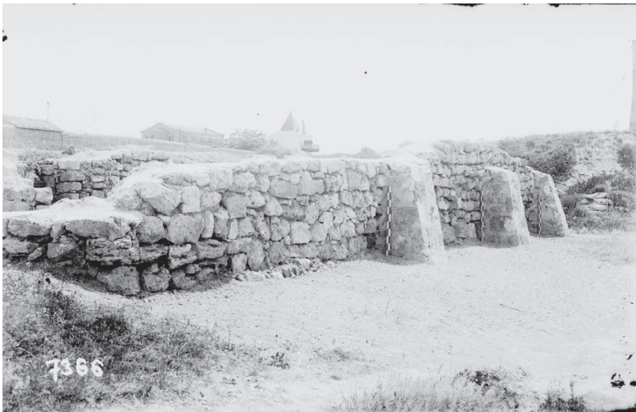
Рис 7. Остатки бани во время консервации 1940 г. Вид с северо-востока. Негатив № 7366.
