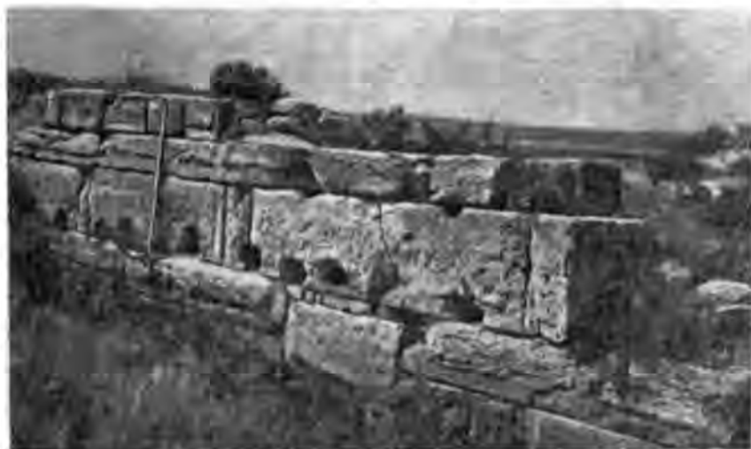
Рис. 4. Внутренний фасад западной стены до раскопок 1929 года.
