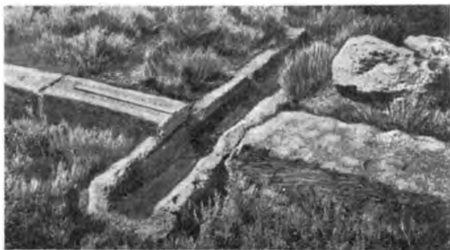
Рис. 6. Водосток в древнегреческой стене к северу от стыка со средневековой стеной.
