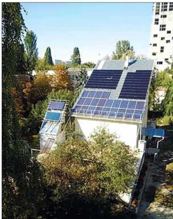
Рис. 2. Загальний вигляд експериментального енерго-ефективного будинку пасивного типу
