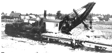
Рис. 1-Паровой экскаватор лопата на ж/д ходу «Путиловец» (1911 г.)
