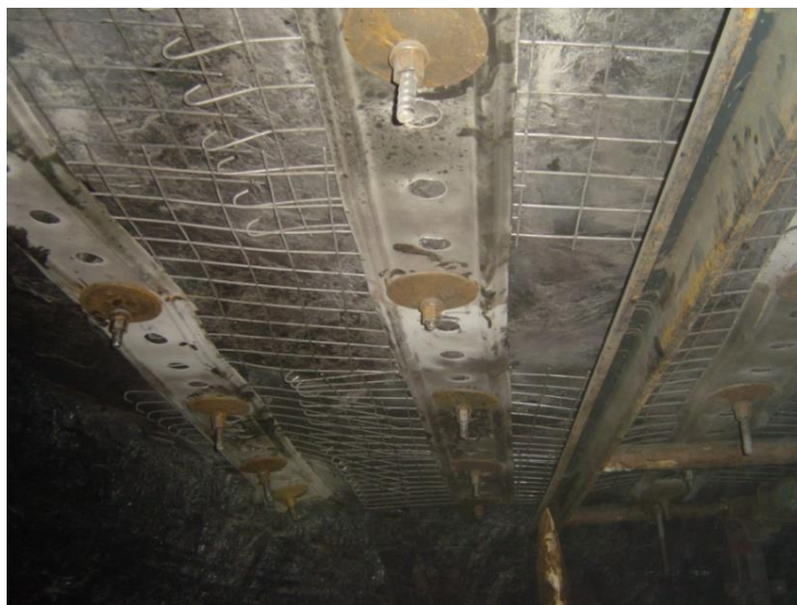
Рисунок 7. Состояние вентиляционного ходка 5 восточной уклонной лавы шахта «Самсоновская-Западная»
