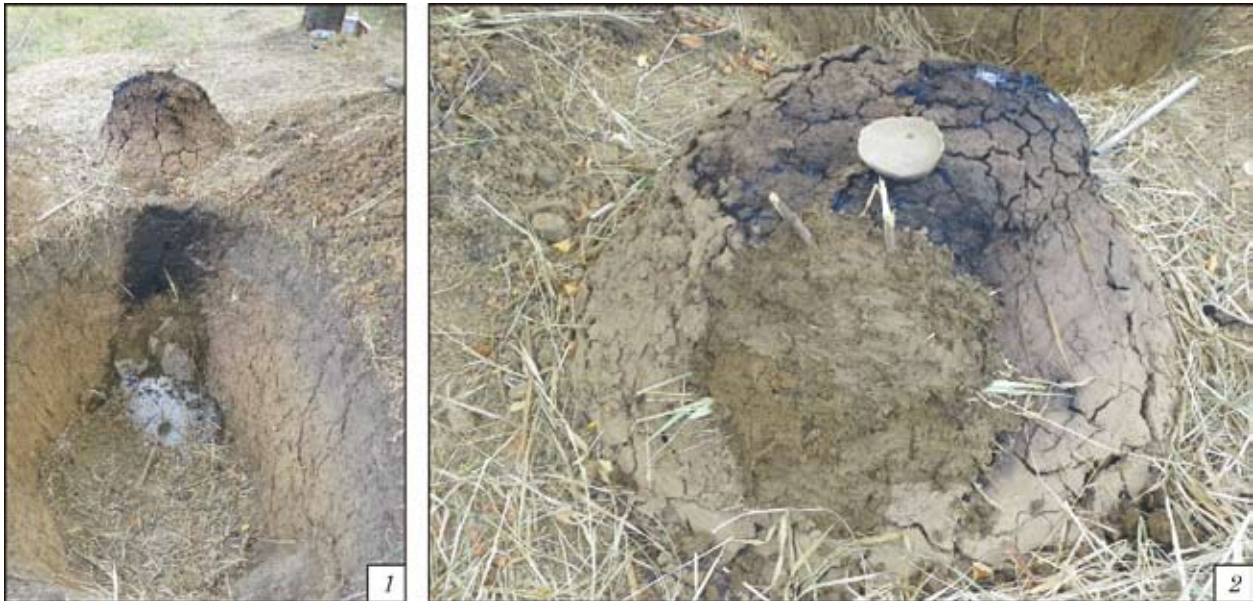
Рис. 12. Закриття топкової камери та продуху у випалювальній камері горна
