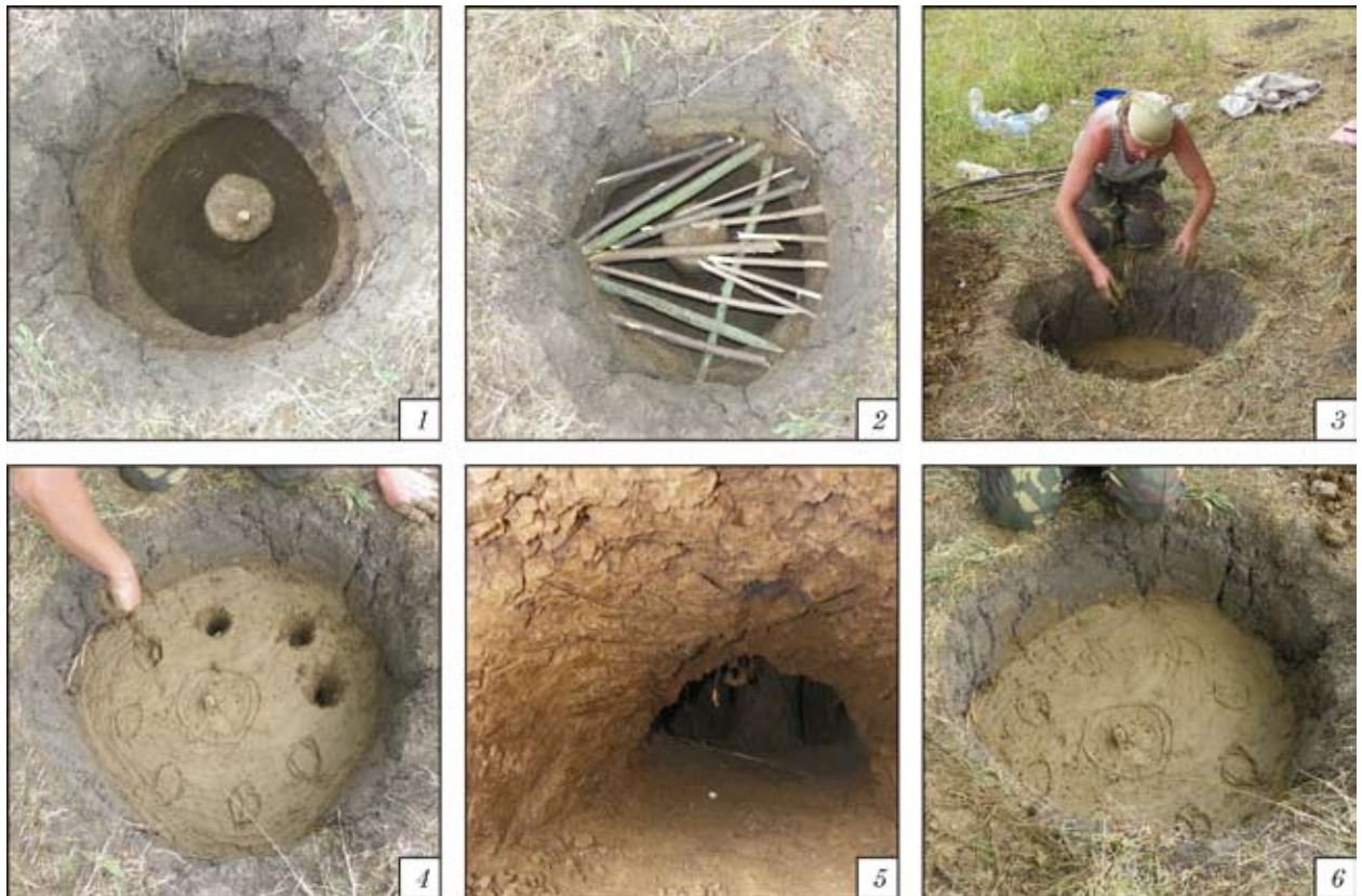
Рис. 4. Спорудження перегородки та куполу опалювальної камери
